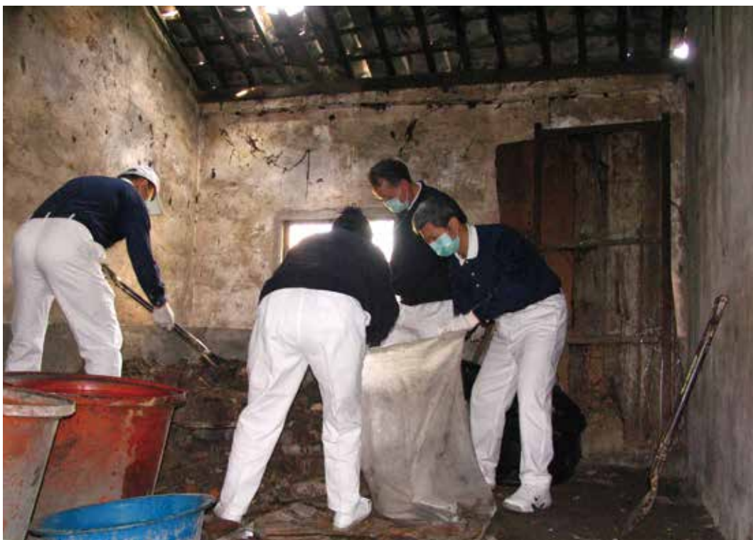
一月十四日另一行人到北港一戶人家，牆上、天花板、屋裡各個角落佈滿累積十餘年的灰塵與蜘蛛絲。圖為醫師們合力整理「浴室」。
