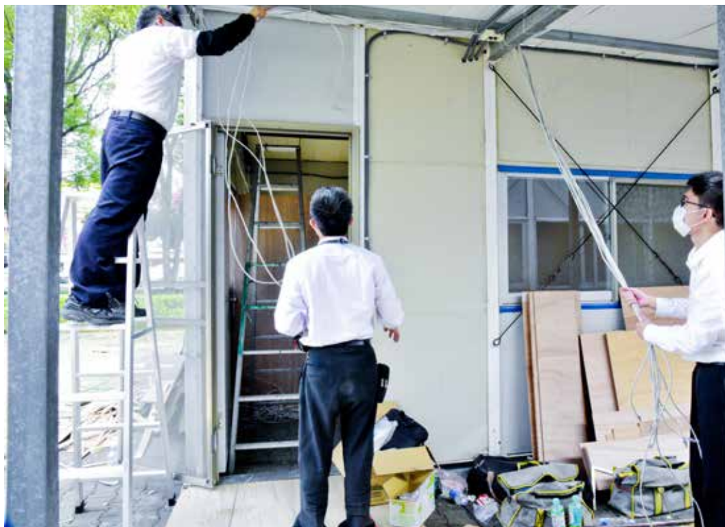
資訊同仁除了軟體程式設計，也要處理硬體端的架設。圖為戶外防疫篩檢站拉線組裝資訊配備。攝影／張菊芬
