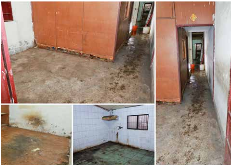
清掃後恢復樣貌。
